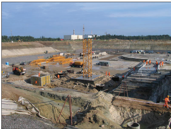
Строительные работы на площадке ЛАЭС-2.
